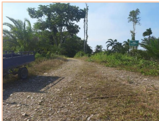
Foto N° 46: Vía no clasificada R2503346
